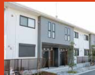
施工事例②
