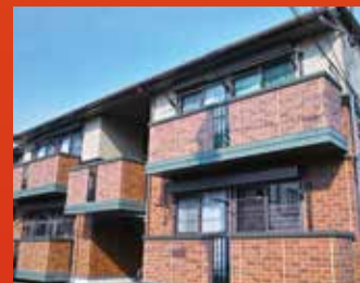
施工事例①
